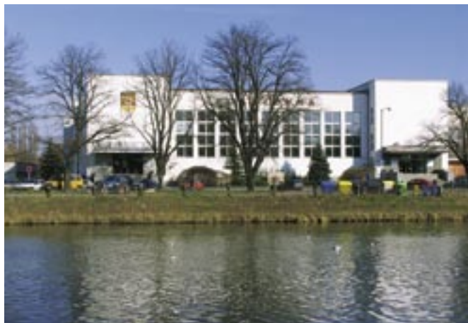
Budova Filharmonie Hradec Králové, nově rekonstruovaný objekt, bude místem jednání VH ČKA 2007.
