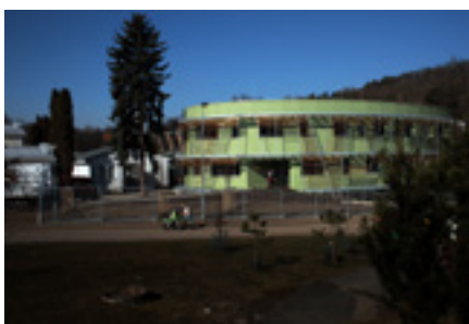
Novostavba pavilonu Z7 v areálu IKEM, Praha 4 – Studio A91 Petr Neřold, Roman Vejmelka – 2014
