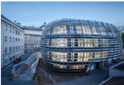
Rekonstrukce a dostavba areálu Ústavu organické chemie a biochemie AV ČR, v. v. i., Praha 6-Dejvice – VPÚ DECO PRAHA, a. s. Kateřina Mašková, Ivan Šrom – 2016
