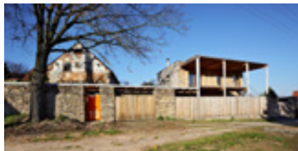
Rekreační objekt Ošelín - MODULORA Jan Alex Řezáč - 2013
