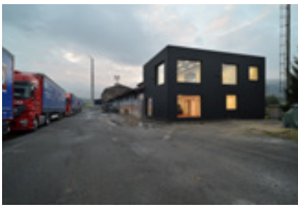
TRANSCO - rekonstrukce, Děčín - 3+1 architekti Pavel Plánička, Bruno Panenka - 2016
