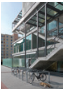
Komunitní centrum Máj, České Budějovice – SLLA Architects Michal Suló, Miriam Lišková, Jozef Skokan – 2014
