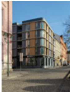
Bytový dům Veleslavínova, Plzeň – AeroPLAN - Radek Dragoun, Jaromír Veselák, AVE architekt, a. s. Radek Dragoun, Jaromír Veselák – 2015
