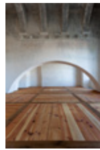
Rekonstrukce severního křídla Jezuitské koleje, Kutná Hora – Atelier M1 architekti, s. r. o. Jakub Havlas, Jan Hájek, Pavel Joba – 2014
