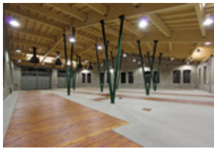
Rekonstrukce topírny Kořenov - ALEJ architektonický ateliér Ivan Lejčar, Petr Lédl, Tomáš Štejfa - 2016
