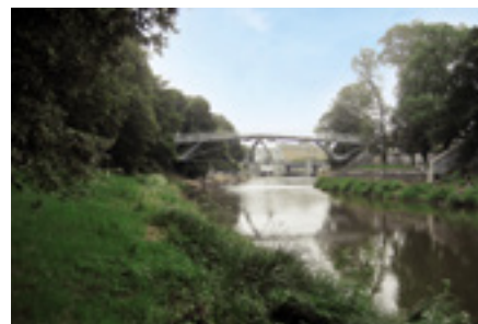
Lávka pro pěší přes Orlici, Hradec Králové - baum & baroš ARCHITEKTI Mirko Baum, David Baroš - 2012
