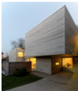
Obytná sestava v zahradě, Praha 9-Horní Počernice - d3D Pavel Valenta, Pavel Rydlo - 2016
