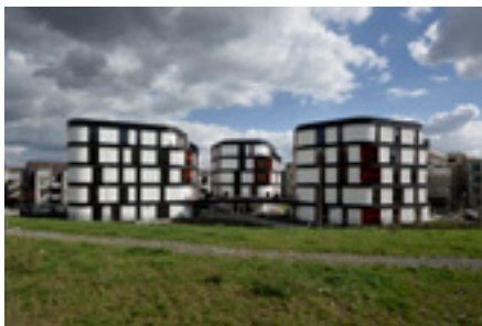
Obytný soubor na Vackové – etapa F, Praha 3-Žižkov – SCHINDLER SEKO ARCHITECTS Ludvík Seko, Jan Schindler – 2016
