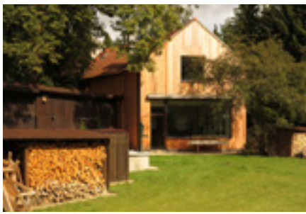
Rekonstrukce domu, jižní Čechy – Atelier K2 Jiří Poláček, Václav Škarda – 2015
