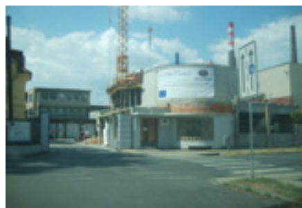
Rekonstrukce objektu vratecnic, přístavba a nástavba školicího centra Crystal Bohemia, Poděbrady - Radek Horník - 2015
