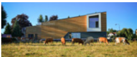
ELADA, víceúčelové centrum Církve bratrské v Bystrém – BITTNER architects, s. r. o. Oldřich Bittner, Klára Bittnerová – 2013
