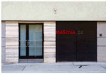
Rekonstrukce domovního parteru a vstupních prostorů, Brno
