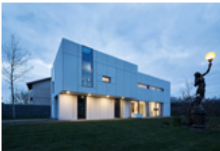
Bílý dům v Újezdě nad Lesy – atelier A11 Jiří Žentel, Alena Žentelová – 2016
