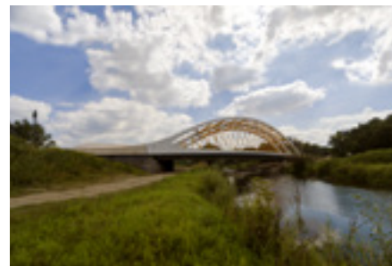
Rekonstrukce železničního mostu přes Dyji jižně od Břeclavi - EXprojekt, s. r. o. Václav Kocián, David Rose - 2016
