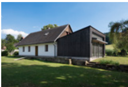
Rekonstrukce rodinného domu, Machov – Chmelař architekti David Chmelař – 2012
