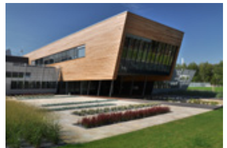
Univerzitní centrum energeticky efektivních budov ČVUT v Praze, Buštěhrad – Šenbergerová, Šenberger – architekti Tomáš Šenberger, Tomáš Med – 2014
