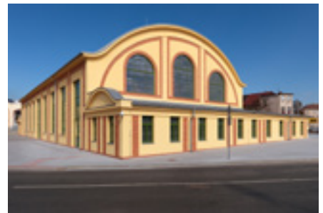
Restaurování první stavby postavené Hetzerovou konstrukcí v Československu, Plzeň - ATELIER SOUKUP OPL ŠVEHLA, s. r. o. Jan Soukup, Jitka Růžičková - 2013
