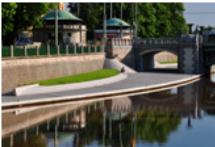
Náplavky pravého břehu Labe, Hradec Králové - Žárovka architekti Vladimír Šolc, Pavel Zadrobílek - 2012
