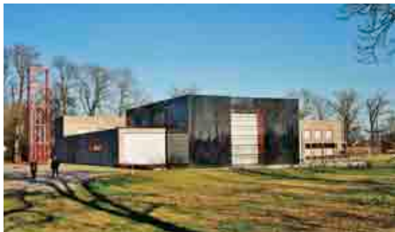
Energeticky plusový farní kostel sv. Františka. Byl postaven z prefabrikovaných dřevěných panelů a obložen černými skleněnými tabulemi s integrovanými fotovoltaickými panely. Kostel vyrobí více elektrické energie, než sám spotřebuje, přebytek dodává do sítě. Autor: Luger & Maul, Wels, Rakousko.
