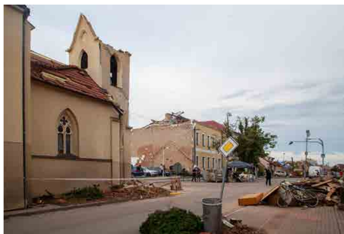
Obec Hrušky s poničeným kostelem sv. Bartoloměje a základní školou. Foto Tadeáš Bednarz
