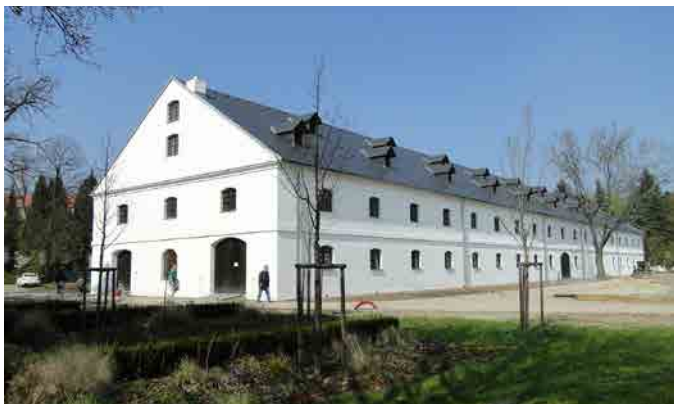
Rekonstrukce bývalého Velkého dělostřeleckého skladu pro interaktivní vědecké centrum „Pevnost poznání“, areál Korunní pevnůstky v Olomouci, autoři: Stašek Žerava, Miroslav Procházka / Ateliér Bonmot, spol. s r. o., Olomouc, realizace 2014. Příkladná spolupráce s památkáři, kteří byli doslova konzultačními členy týmu. Foto archiv autora
