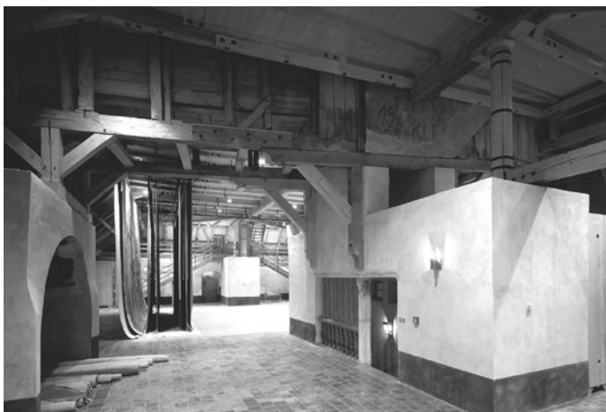
Václav Girsá, rekonstrukce barokního divadla, Český Krumlov, 1980–2000
