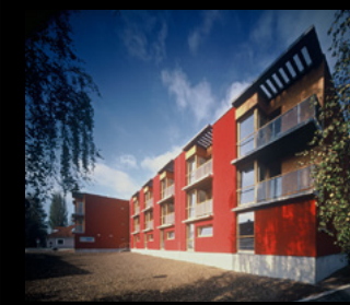
Bytový dům se startovacími byty v Třeboni, autoři: S.H.S architekti / Martina Buřičová, Lukáš Holub, Lubor Sladký, soutěž: 1999, realizace: 1999–2001
