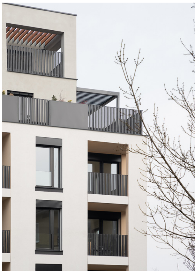
Detail jižní fasády
