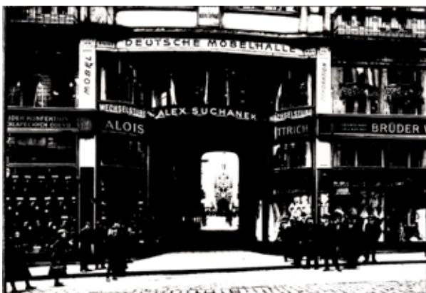
1) Parter domu v Průchodní, rok 1910, architekt Maxmilian Monter.
