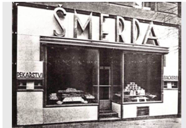
5) Pekařství Šmerda, architekt Zoltán Egri.
